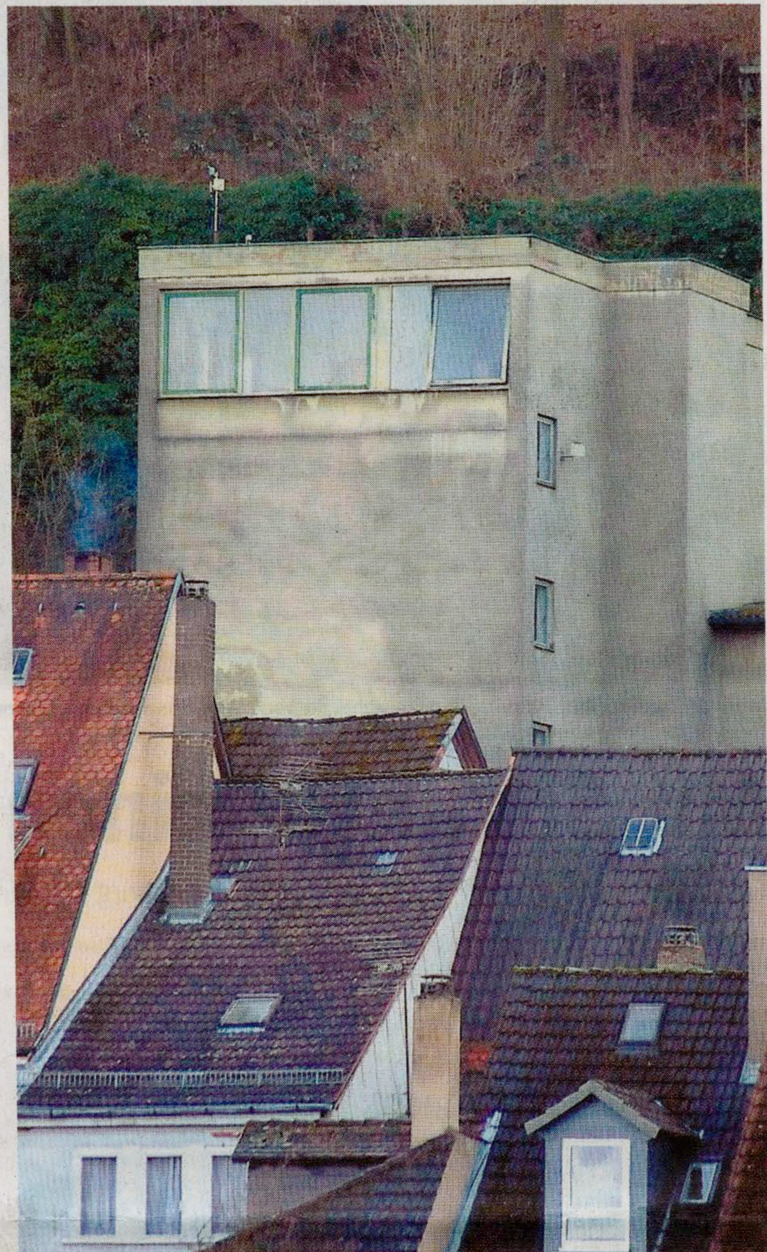
Im Turm der Brauerei Faust wird in den kommenden Monaten ein Kreativ-Sudhaus eingerichtet. Dabei wird die Bausünde aus den 60er-Jahren auch mit einem Balkon und einem neuen Anstrich optisch aufgewertet.
